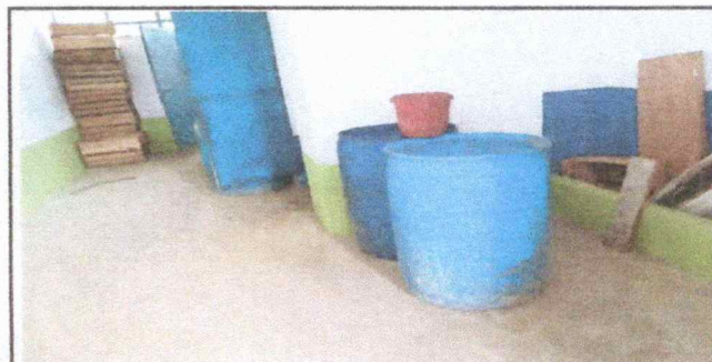
Foto 4: Teniendo el espacio en el centro educativo no contamos con el servicio de baños para nuestros estudiantes, por el mal estado de drenajes, mal estado de los sanitarios y la red de agua entuvada se encuentra colapsada en el interior del mismo.
